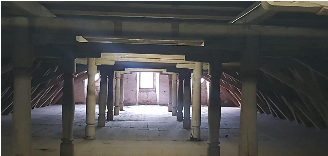
Das erste von drei Dachgeschossen, die Decke noch mit Balken gestützt.
