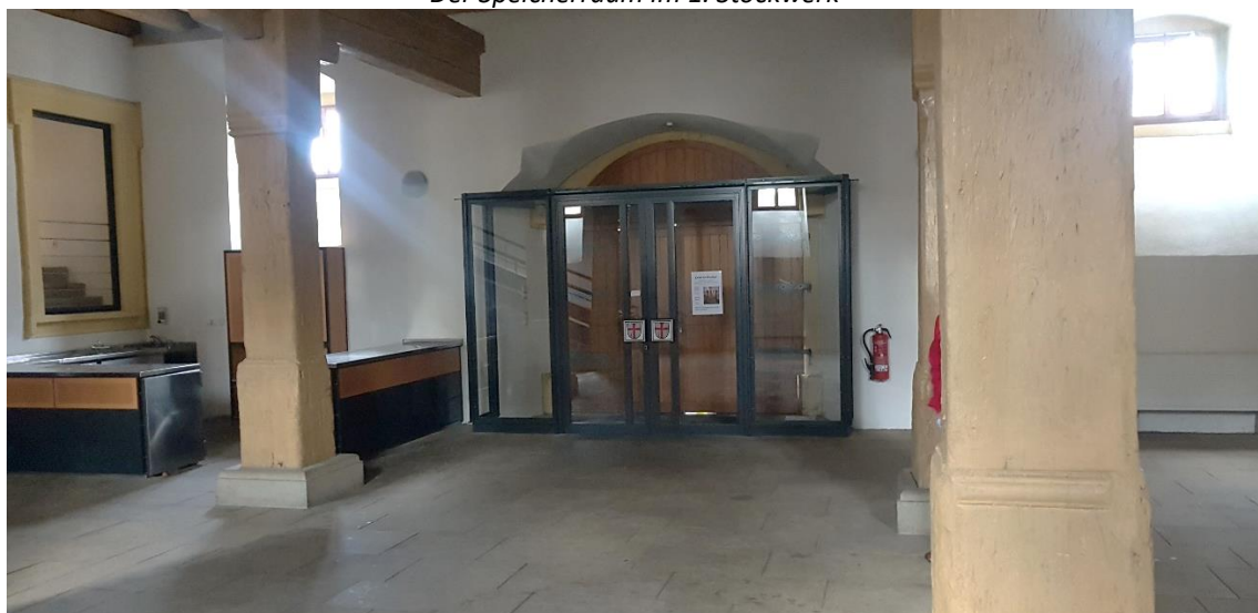
Das Erdgeschoss war durch ein großes Tor für Fuhrwerke befahrbar und so konnte im Trockenen entladen werden.
