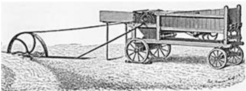
Von Wasser angetriebene Dreschmaschine
