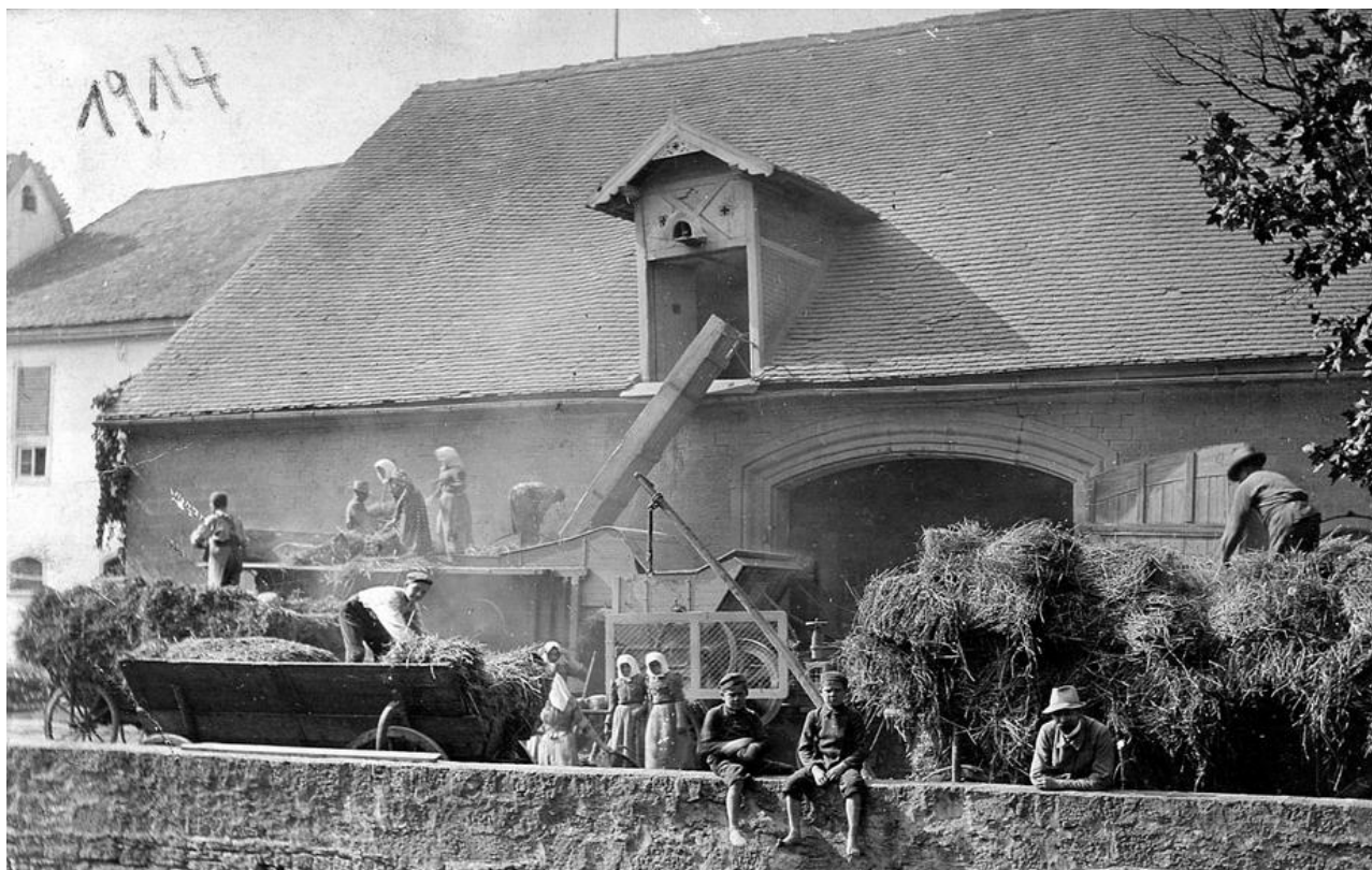
Scheune des Gasthauses Bötsch – evtl. 1914; vorne rechts an der Mauer mit Hut: evtl. Josef Bötsch
